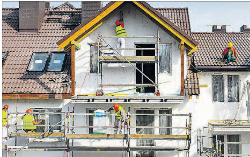
Energetische Sanierung: Eine verbesserte Gebäudeisolation reduziert den Energieverbrauch und steigert den Gebäudewert. (Bild: zVg.)
