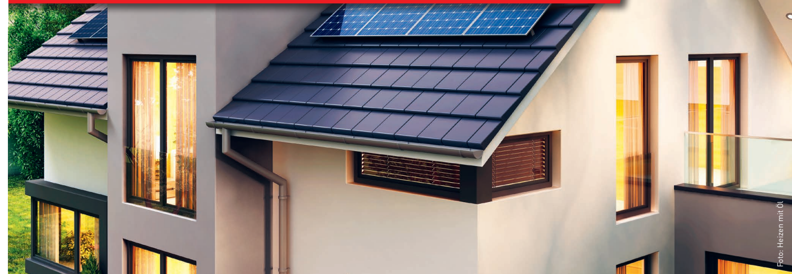
Bei Photovoltaikanlagen wird das Sonnenlicht mithilfe der Solarzellen zur Herstellung elektrischer Energie genutzt.
