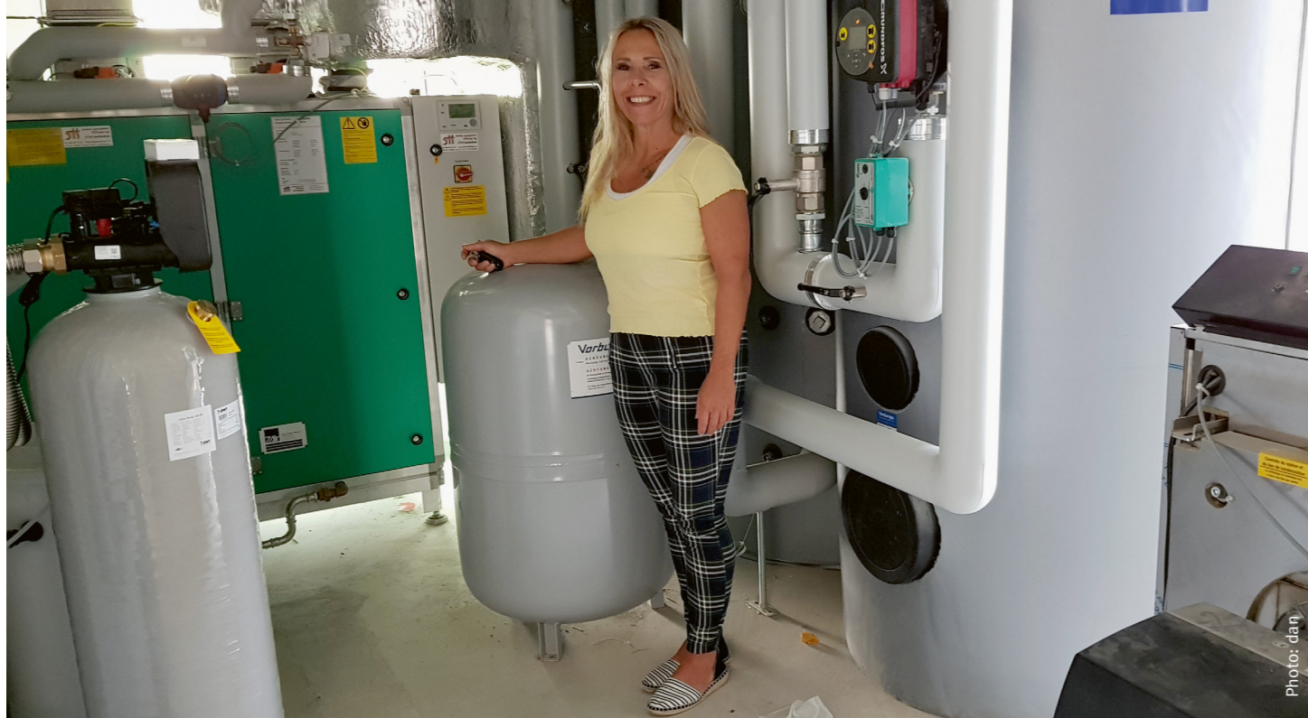
Karin Hunziker-Soland: «Un chauffage au mazout moderne, à condensation, se justifie même d'un point de vue écologique.»
